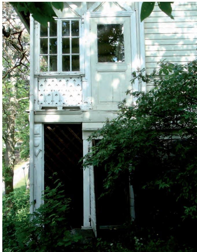
Detalji terrasin pilarista ja kaiteesta. Julkisivut on maalattu lateksilla, maali irtoaa yhtenäisinä levyinä. Oikealla purettuun terassiportaan paikka ja ovi sokkeliosaan.
