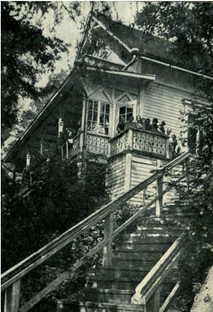
Terassin päädyssä oli lasiseinä ja lasiovi, jotka edelleen on tallella, vaikka porras on purettu.
