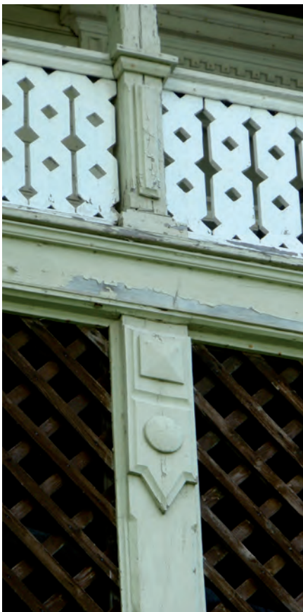
Detalji terrasin pilarista ja kaiteesta. Julkisivut on maalattu lateksilla, maali irtoaa yhtenäisinä levyinä. Oikealla purettuun terassiportaan paikka ja ovi sokkeliosaan.
